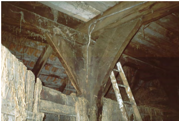
Abb. 5: Knotenpunkt eines Innenständers mit den mächtigen Kopfbändern und Balken.
