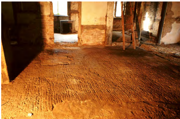
Abb. 6: Nach Entfernung des jüngeren Estrichs kam ein seltenes Kieselplaster zutage. Die große Überraschung: In der Mitte des Hauses war die frühere Herdstelle, aus Rotsteinen gepflastert, erhalten geblieben.
