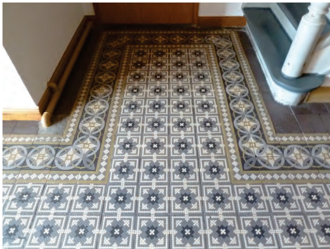
Abb. 4: Detail zu Abb. 3. Statt einer Lehmziele wurde der Flur mit gemusterten Fliesen belegt.
