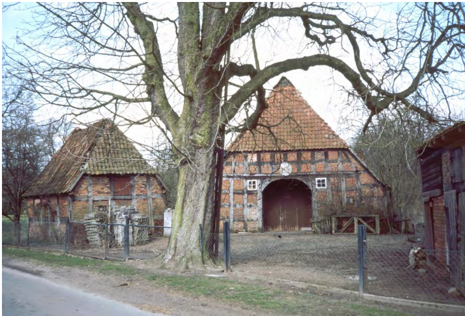
Abb. 1: Der Hof Eitze Nr. 9 vor der Restaurierung, links der kleine Fachwerkstall, rechts das Niederdeutsche Hallenhaus, entstanden im Dreißigjährigen Krieg.
