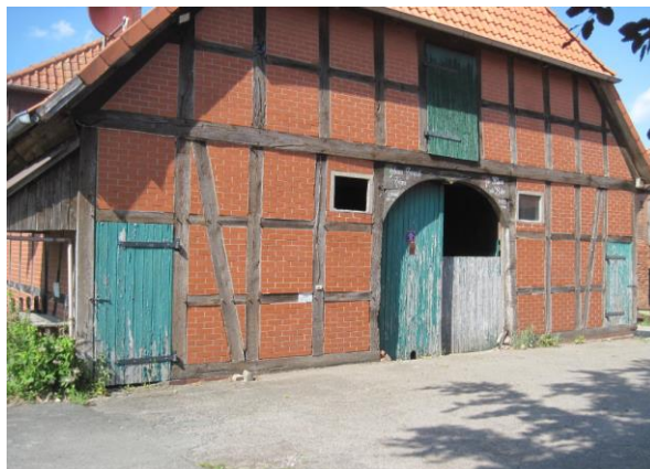
Giebel in Fachwerk mit farbigen Toren
