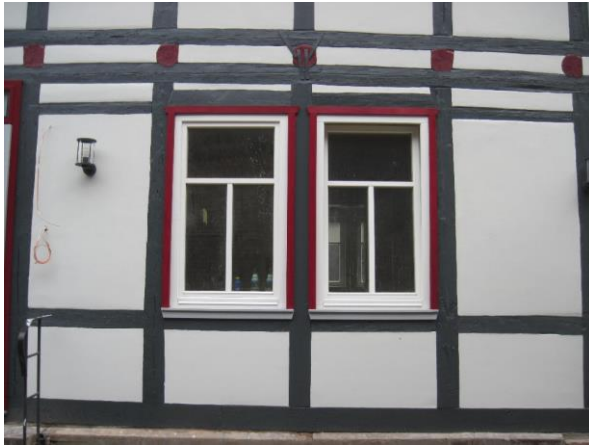
Fenster mit T-Teilung in einer Fachwerkwand
