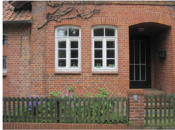
Erneuerte Fenster in einer Ziegelfassade
