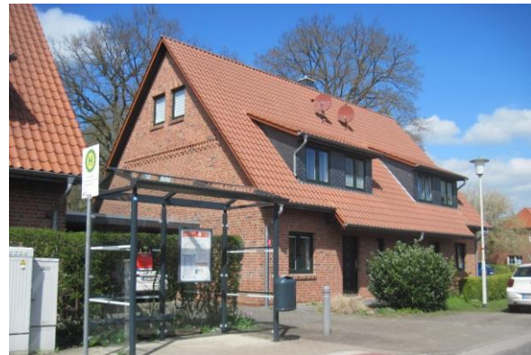
Passender Neubau im dörflichen Kontext
