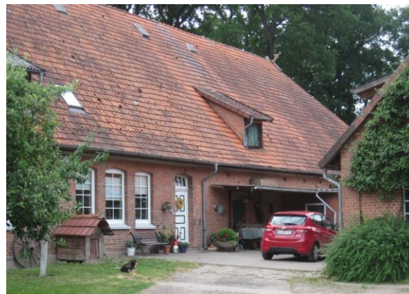
Kleiner Ladeerker als Zugang zum Dachraum
