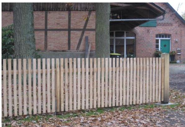
Holzstaketzaun mit schmalen Latten
