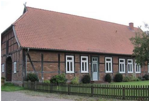
Langgestreckter, lagerhafter Baukörper
