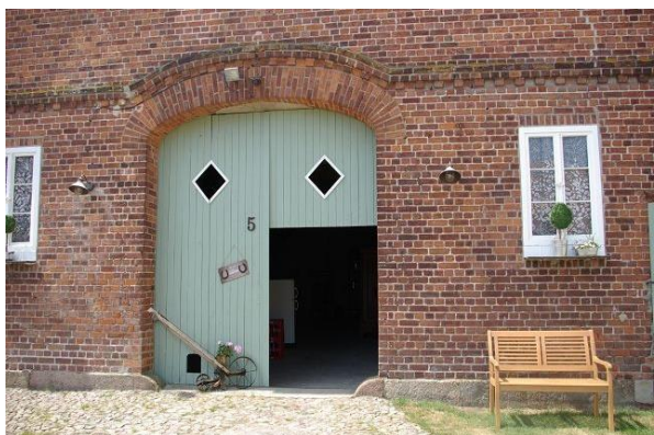
„Groot Dör“ mit Klöntür und Oberlicht
