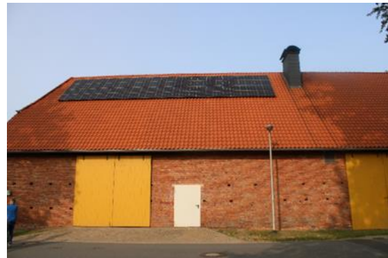
Dach-PV-Anlage und Holzhackschnitzelheizanlage für ein Wärmenetz in Neddenaverbergen
