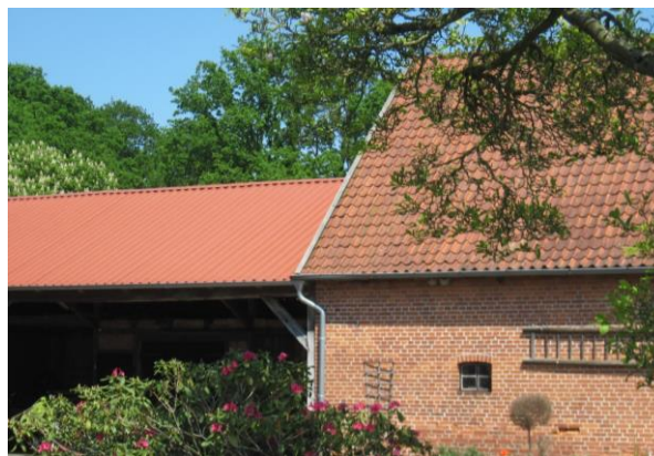
Kombination von Tonziegeln und Profilblech
