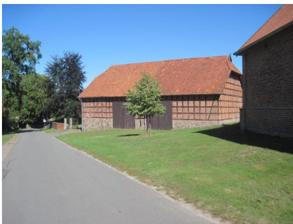
Nebengebäude mit Boden-Deckel-Schalung
