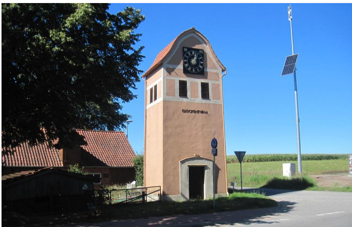
Der Glockenturm markiert den Beginn des Ortskerns von „Nedden“ aus Richtung Kirchlinteln kommend.
